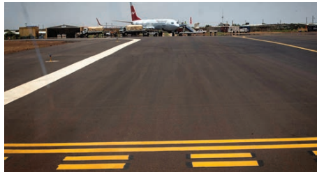
La nouvelle piste de l'aéroport international de Gao.
